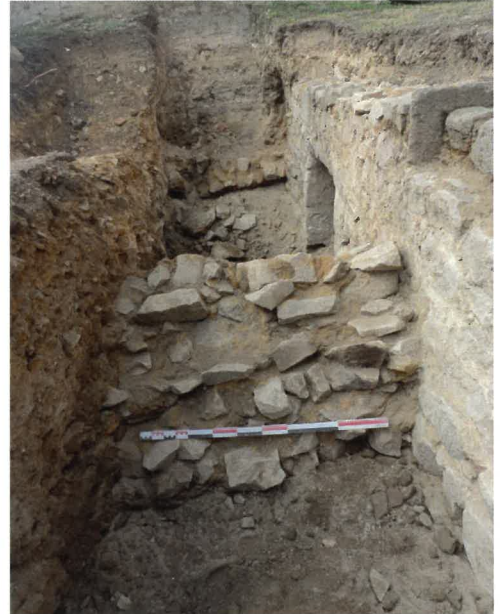
CLOITRE : Vue de l'extrados du départ de voûte et porte de la cave (Mire de 1 m)
