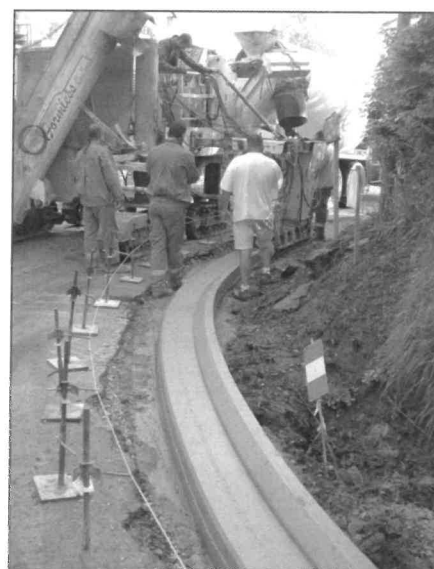
Réalisation des bordures de la VC 10 en continu Entreprise LABBE TP - Confolens
